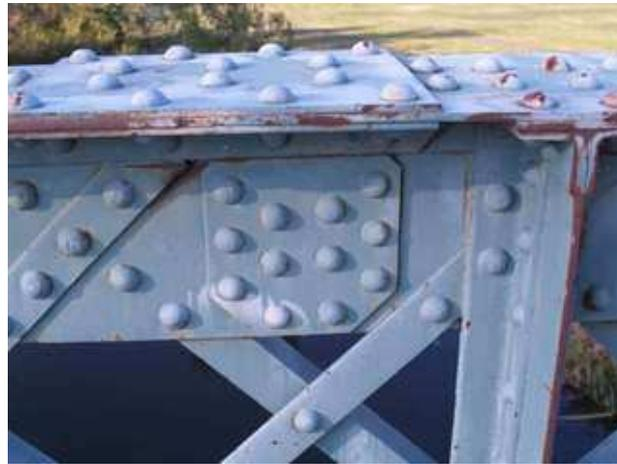
Le but de ce document est de préciser rapidement les différentes opérations effectuées lors de la réparation d'éléments rivetés (ouvrages d'art, charpentes métalliques, tours, conduites forcées, citernes, ...). Ces ouvrages ont été généralement réalisés à la fin du 19<sup>ème</sup> ou au 20<sup>ème</sup> siècle, et doivent être réhabilités.
